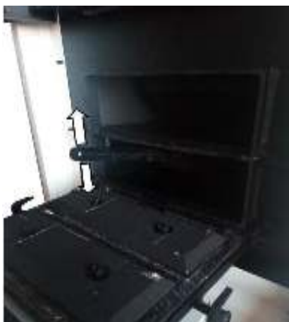
Figura 19: Curățarea generatoarelor de turbulențe
